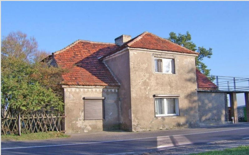
Nowa Sól - dawny domek szosowy przy drodze wojewódzkiej 292. Stan w 2018 r.
